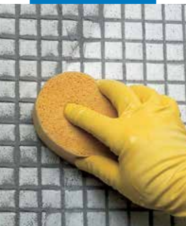
Finisarea chitului de rosturi aplicat pe mozaic de sticlă cu un burete dur din celuloză
