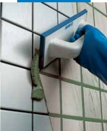
Intinderea chitului Ultracolor Plus pe perete cu spatula din cauciuc
