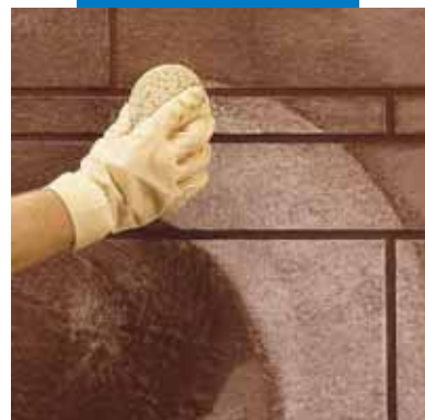
Curatarea si finisarea rosturilor pe perete cu un burete
