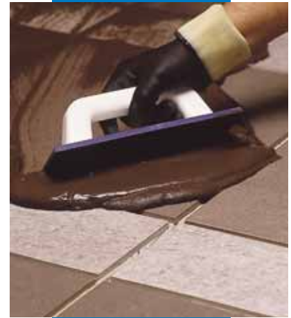
Intinderea chitului Ultracolor Plus pe pardoseala cu spatula din cauciuc
