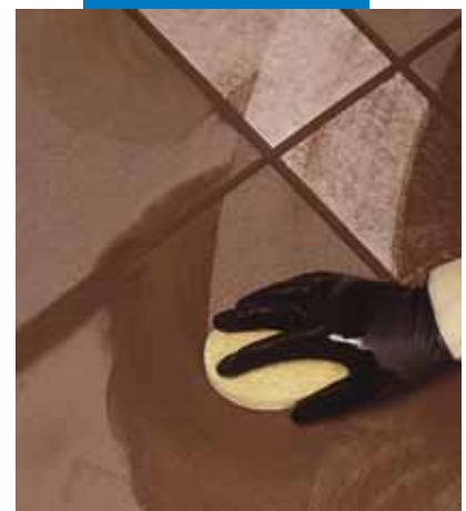
Curatarea si finisarea rosturilor pe perete cu un burete
