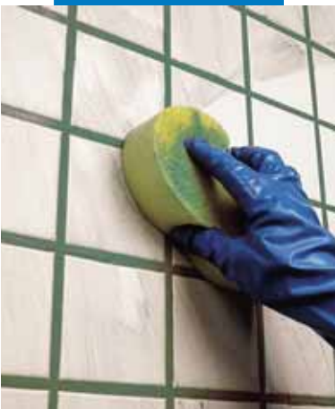
Curatarea si finisarea rosturilor la perete cu un burete
