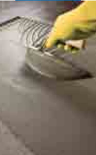
Aplicarea adezivului Kerabond T-R pe pardoseala
